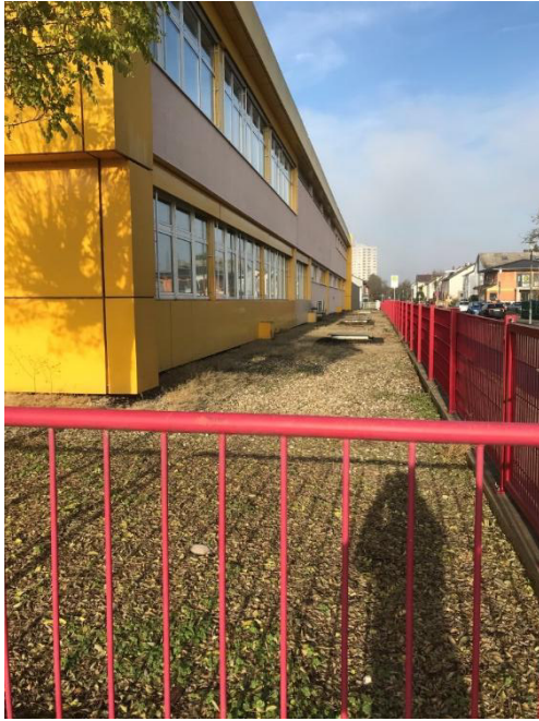
Abb. 4: Gebäudebestand (eigene Aufnahme, 18.12.2018)
