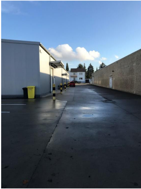
Abb. 4: Gebäudebestand (eigene Aufnahme, 18.12.2018)
