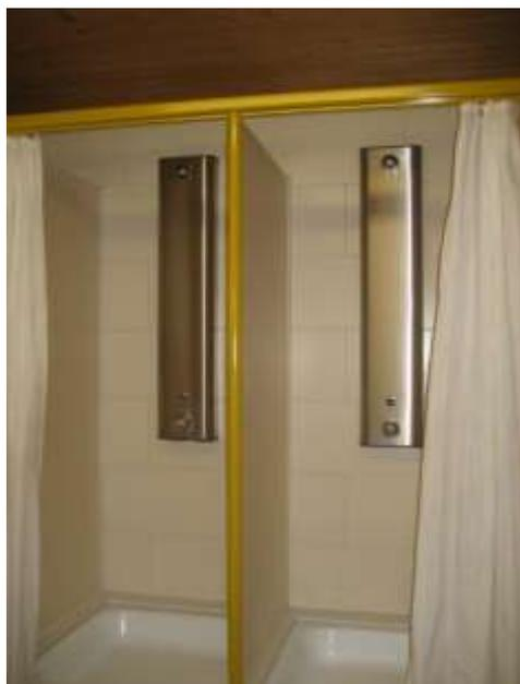
Ende des Jahres wurden an den Duschen Thermostatmischer eingebaut. Dies stellte sich während der Durchführung als größere Baumaßnahme dar, die nicht im Rahmen einer normalen Belegung möglich gewesen wäre. Durch den Einbau konnte die Verbrühungsgefahr der Kinder beim Duschen gebannt werden.
