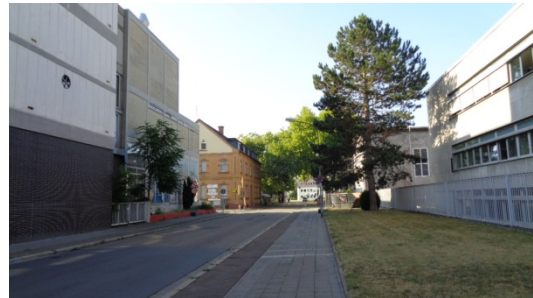
Abbildung 4: Blick auf die ehem. Frankenthaler Brauerei
