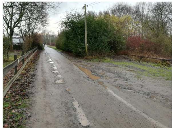
Abbildung 2: Dammtrasse und Parkplätze Blick nach Süden
