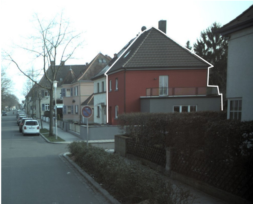
Blick auf die Nord- und Ostfassade der Hannongstraße 26
