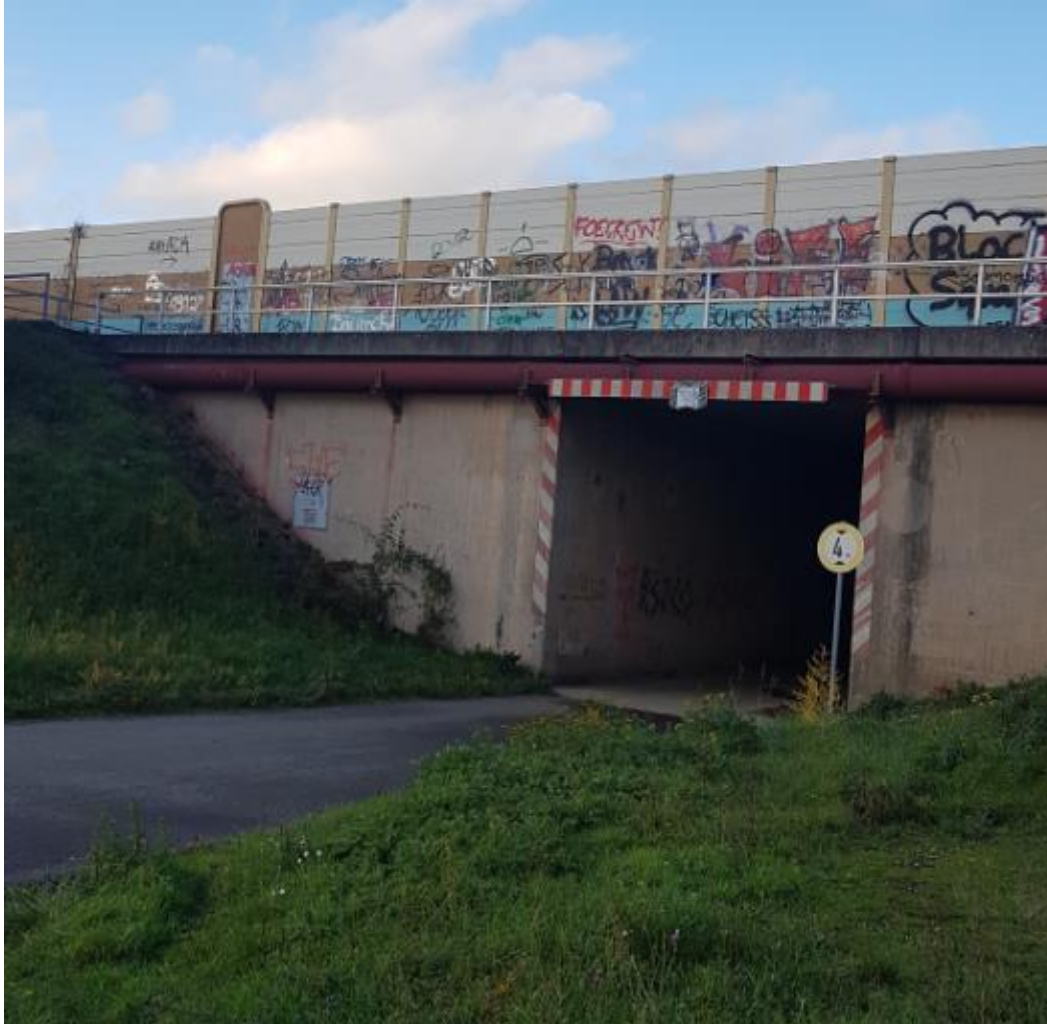
Bild 24: Wirtschaftsweg im Bereich der Autobahnunterführung nördlich von W5
