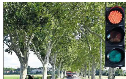
Während der Sanierung zeitweise halbseitig gesperrt und mit einer Ampel ausgestattet: die Flomersheimer Allee.
