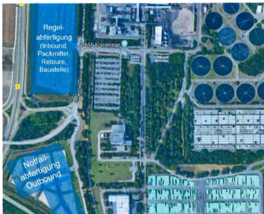
Abbildung 16: LKW-Abfertigung auf der derzeitigen Notfall- fläche Z610
