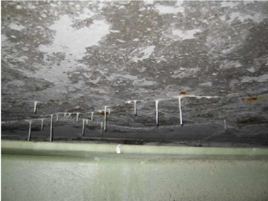
Abb. 4: Riss mit Wasseraustritt an der Überbauunterseite, Prüfbericht 2017
