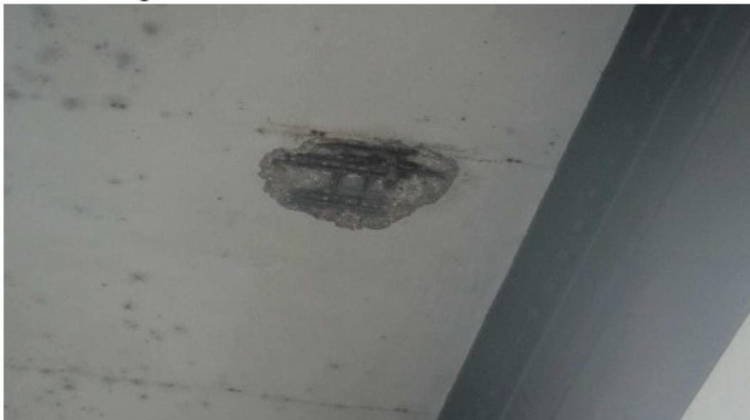
Abb. 5: Abplatzung mit freiliegender Bewehrung, Prüfbericht 2017
