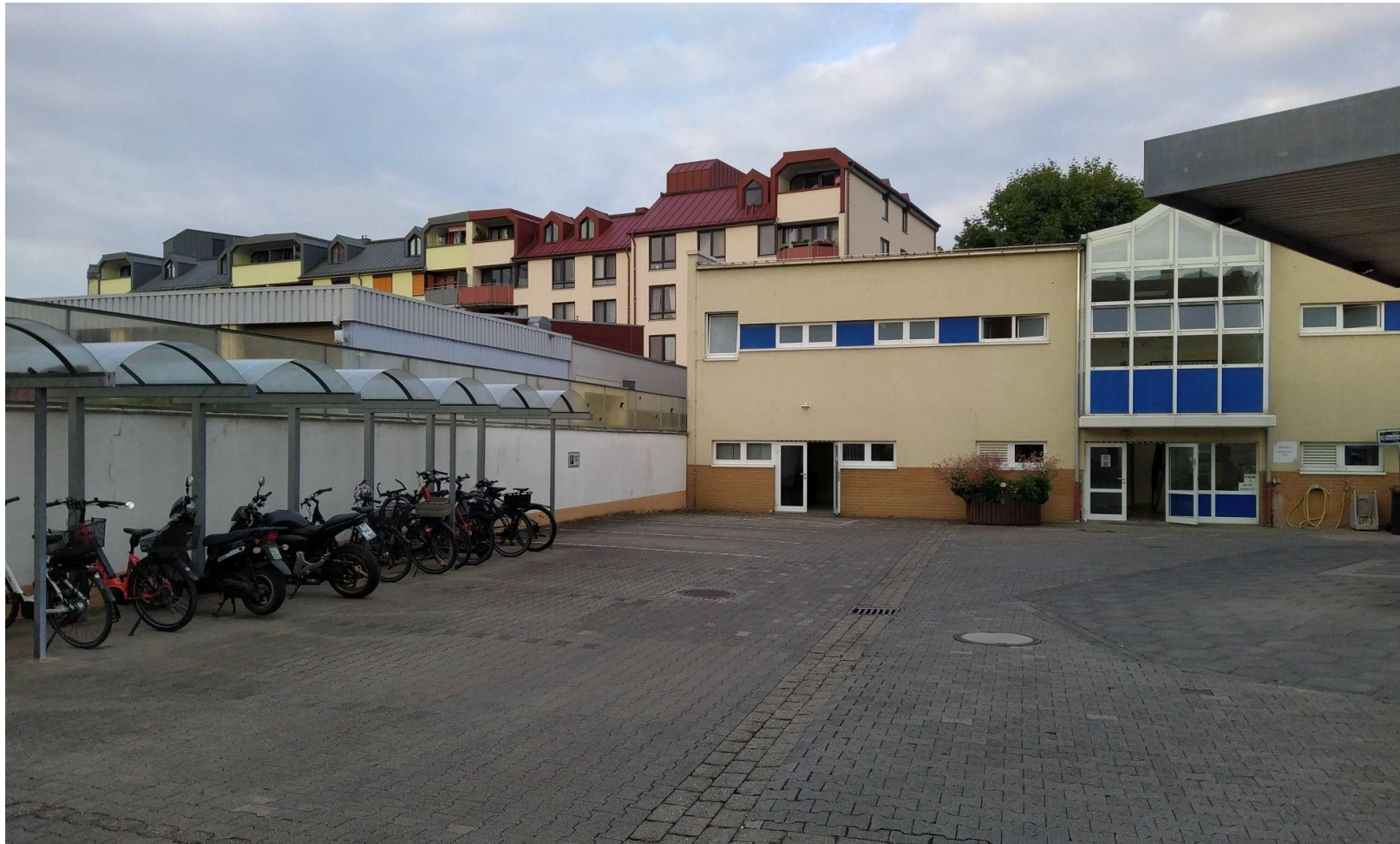
Bild 2. Blick von Osten in Richtung Westen auf die geplante Aufstellfläche (Im Hintergrund: Das Sozialgebäude)
