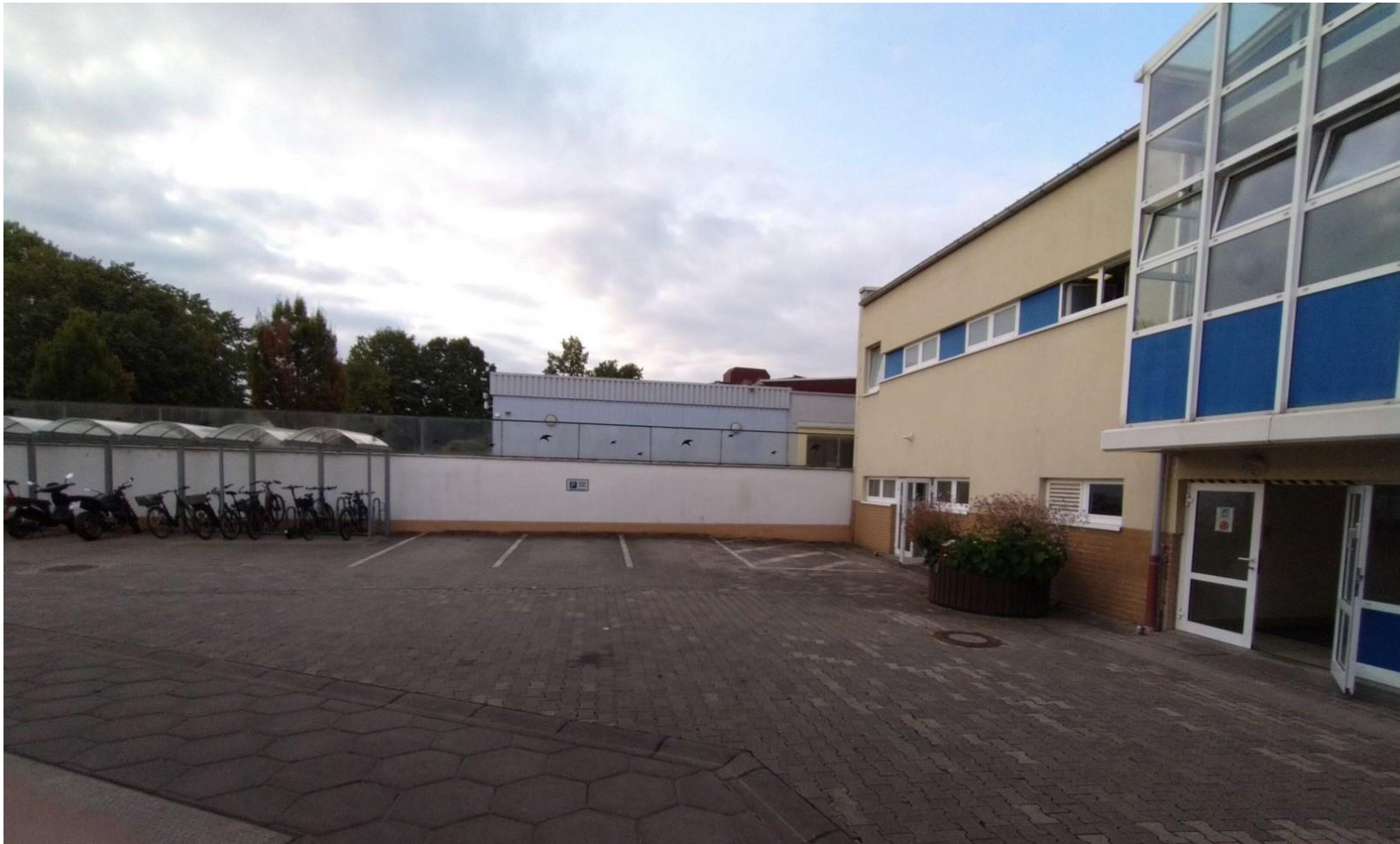
Bild 1. Blick von Norden in Richtung Süden auf die geplante Aufstellfläche
