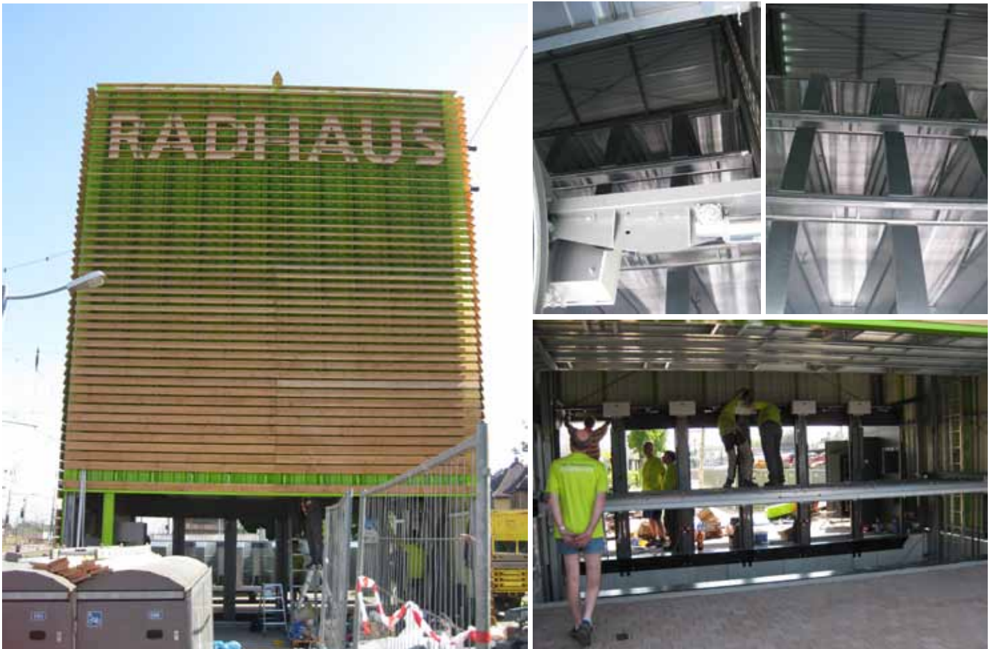
Tag 8 : Beginn der ersten Testfahrten Die Holzfassade ist fertig montiert. Die Fahrradboxen werden eingebaut.
