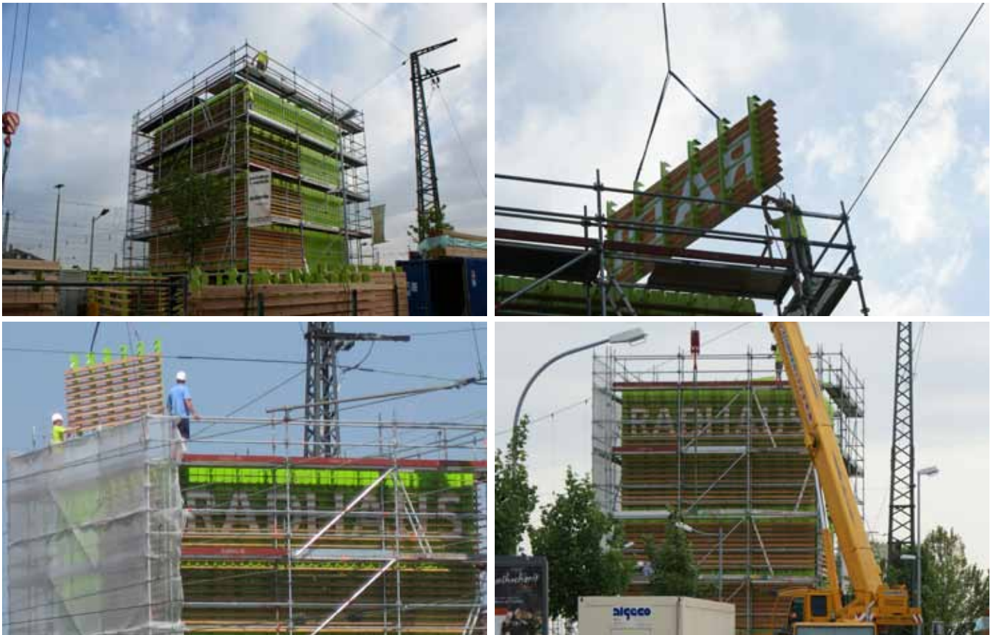
Tag 6 : Montage der Holzfassade
