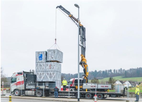
(Minimale Standfläche bedeutet geringe Aushubarbeiten und geringe Betonmasse. Der einmalig schnelle Aufbau am Standort dank modularer Bauweise spart weitere Ressourcen.)
