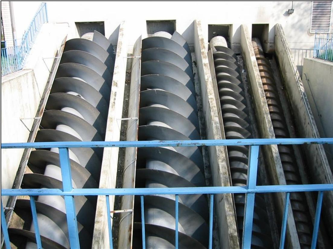
Abbildung 3: PW Am Kanal - Blick auf die Schneckenpumpen
