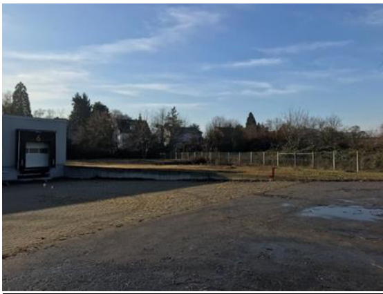
Abb. 4: Versiegelte Hoffläche und Rasenfläche (eigene Aufnahme, 18.12.2018)
